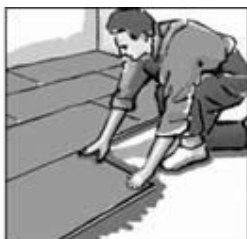
Б Укладываем панели со смещением швов на клеевой раствор.
